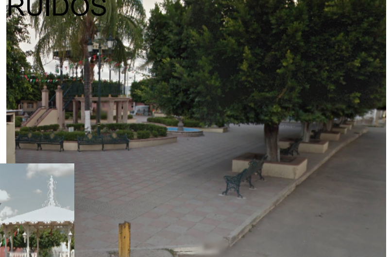
Remodelación Plaza Ahuatlán Zapotlan del Rey, Jalisco
